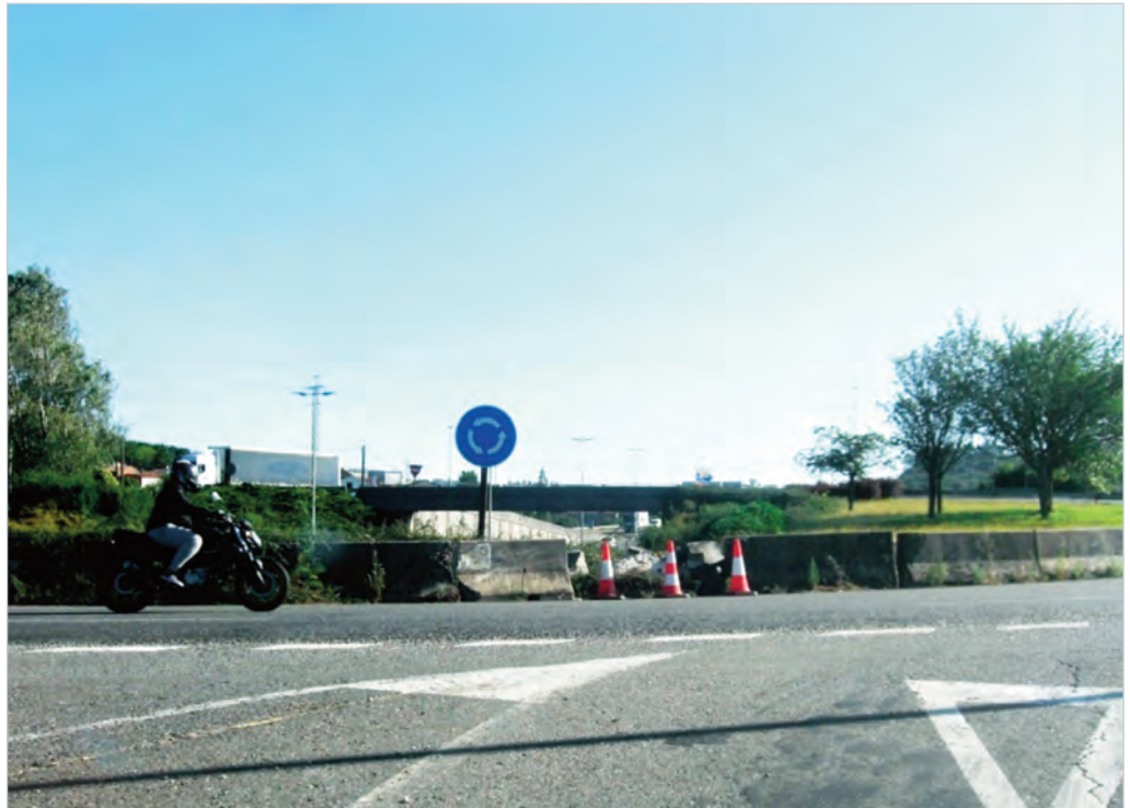
Fotografía 4.- Situaciones críticas debido a la escasa deflexión. (Fuente: Autores de las recomendaciones)
