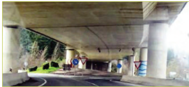
Fotografía 25.- Ubicación inadecuada. (Fuente: Autores de las recomendaciones)
