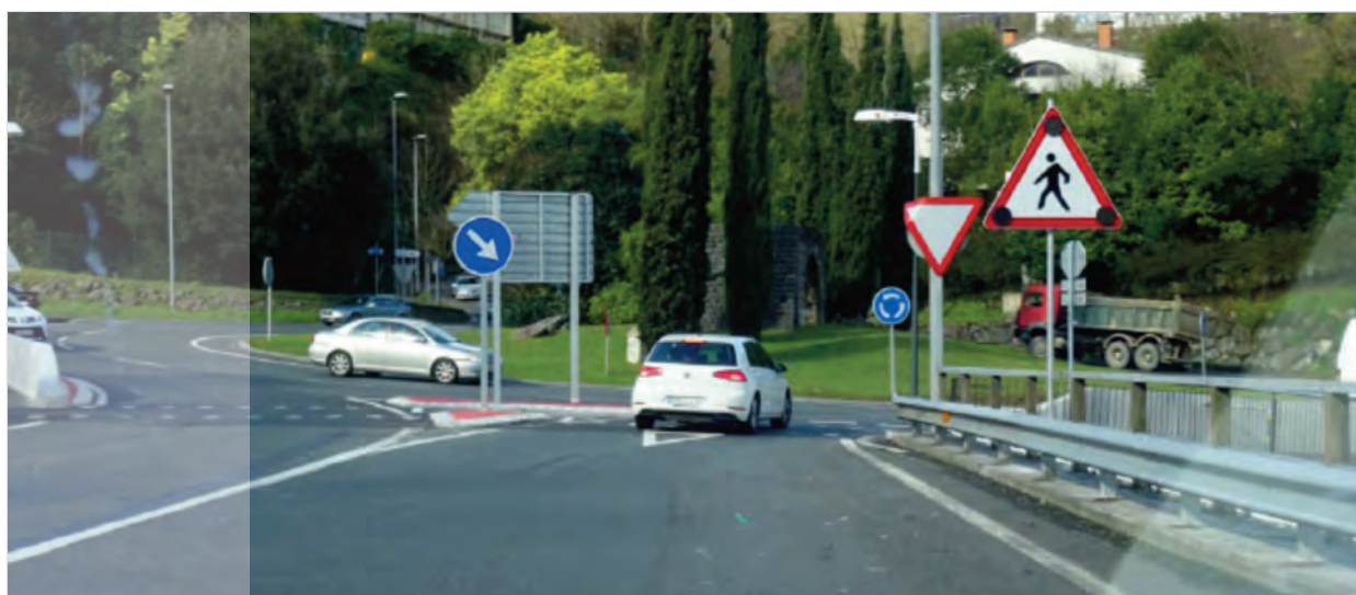
Fotografía 10.- Zona de cruce en la que la señal P-20 está demasiado cerca del cruce y éste no se percibe adecuadamente.
