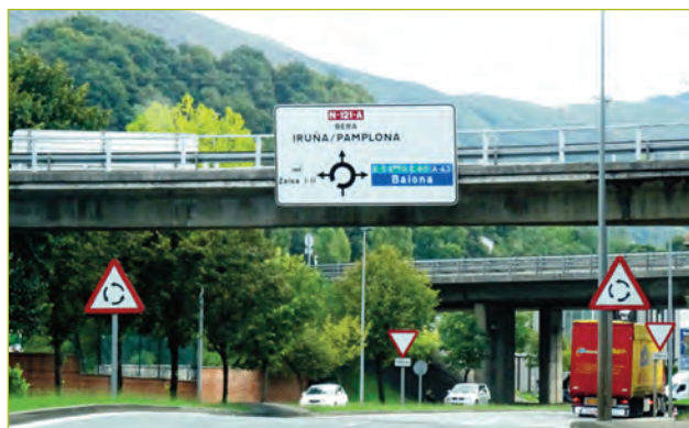
Fotografía 17.- Tamaño de signos y letras en pórtico. (Fuente: Autores de las recomendaciones)
