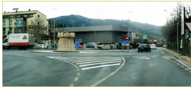
Fotografía 21.- Velocidad elevada en glorieta. (Fuente: Autores de las recomendaciones)
