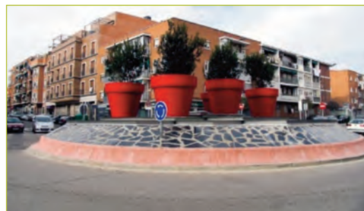
Fotografía 23.- Objetos de gran masa en anillo central. (Fuente: Autores de las recomendaciones)
