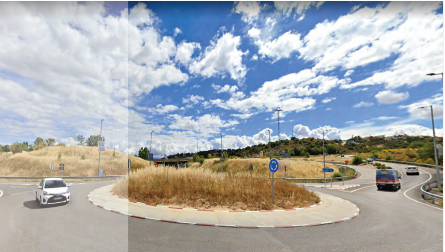
Fotografía 13.- Glorieta con isleta central de bajo mantenimiento. (Fuente: Autores de las recomendaciones)
