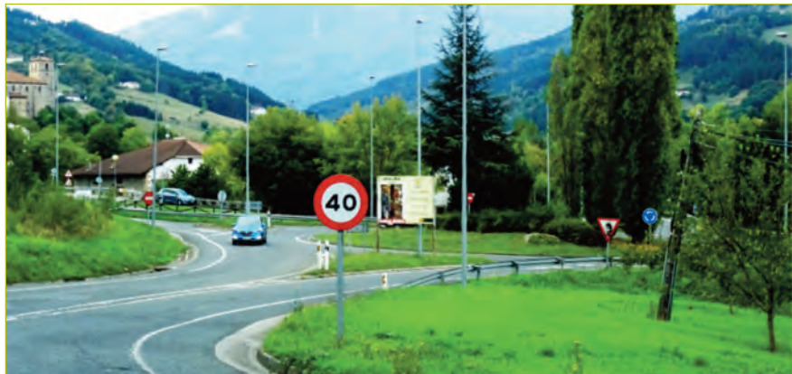
Fotografía 20.- Geometría incorrecta. (Fuente: Autores de las recomendaciones)
