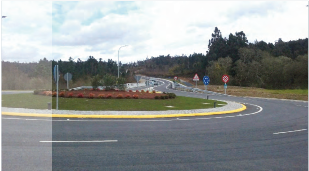
Fotografía 8.- Ejemplo de pintura en bordillo. (Fuente: Autores de las recomendaciones)
