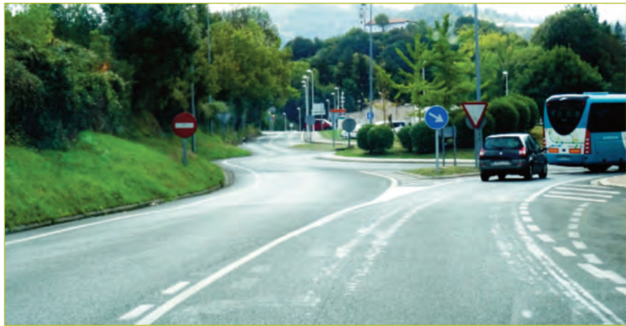
Fotografía 19.- Geometría incorrecta. (Fuente: Autores de las recomendaciones)
