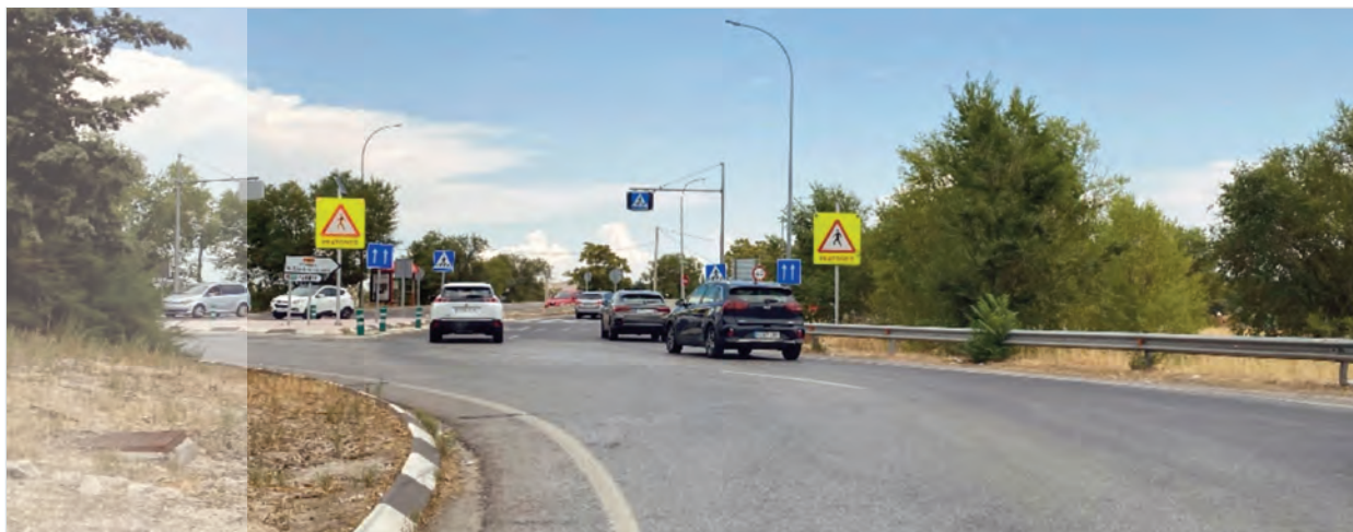
Fotografía 11.- Señalización de refuerzo para la identificación de un paso peatonal.
