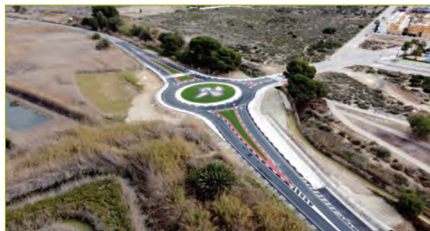
Fotografía 27.- Urbanización el Oasis (Valencia). (Fuente: Autores de las recomendaciones)
