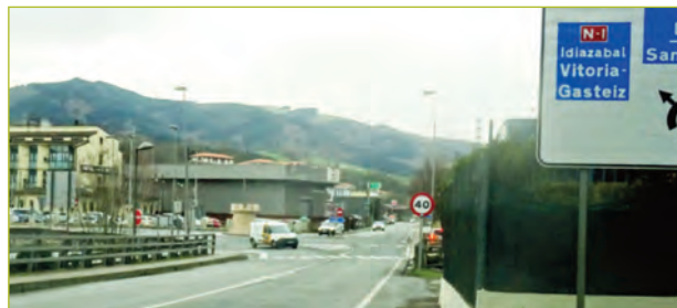
Fotografía 22.- Velocidad elevada en glorieta. (Fuente: Autores de las recomendaciones)
