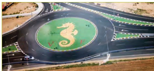
Fotografía 28.- Urbanización el Oasis (Valencia). (Fuente: Autores de las recomendaciones)
