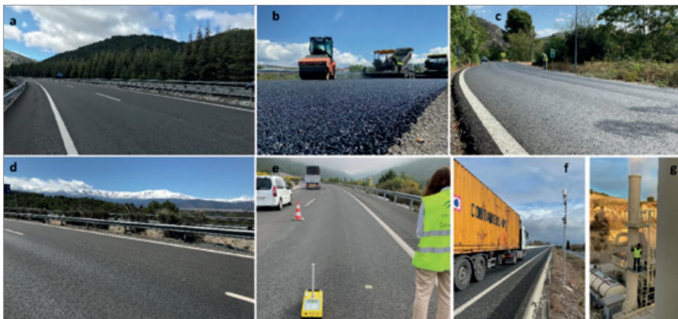
**Figura 2.** Detalle de algunos de los tramos y trabajos realizados con MASAI hasta la fecha: (a) MASAI (I) A-92 Puerto de la Mora; (b) MASAI (I) A-4028; (c) MASAI (II) A-4026; (d) MASAI (I) A-92 Guadix; (e) Control de evolución de propiedades; (f) control de emisiones en servicio A-92; (g) control de emisiones durante producción.
