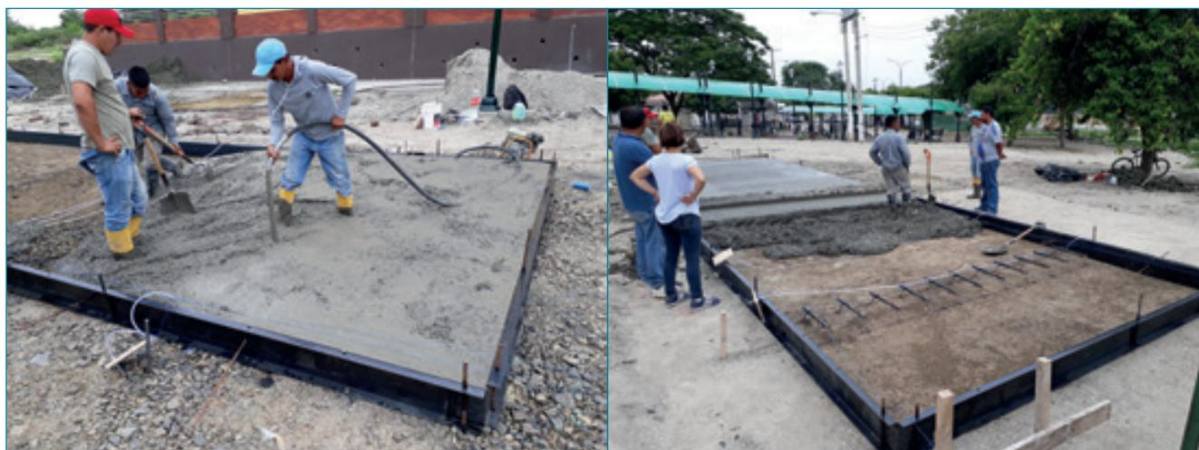
Figura 2. Proceso de hormigonado de las losas.
